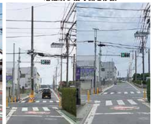
福原地区交差点内にあった電柱及び信号機を移設
