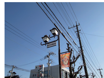
◀設置されたLED街路灯(県内の事例)
